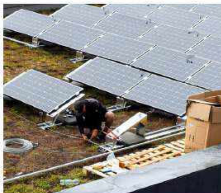
Abbildung 7: Montage einer PV-Anlage auf ein bestehendes Gründach.
