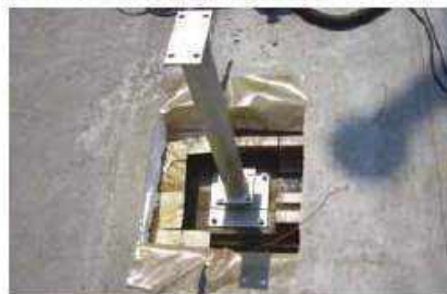
Bild 6: Einbindung Montagesystem (Quelle Schletter)
