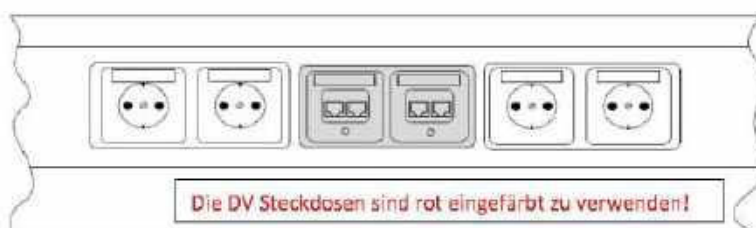
Abbildung 13: Beispielhafte Ausstattung eines Standard-DV-Arbeitsplatzes im Tertiärnetz mit Kupfer-Verkabelung
