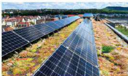
Abbildung 3: Photovoltaik und Gründach sind unmittelbar auf der selben Fläche verbunden. Hier sind die Module in eine Richtung ausgerichtet.
