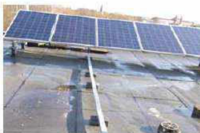
Bild 14: nicht fachgerechte Leitungsverlegung (Quelle VGH)
