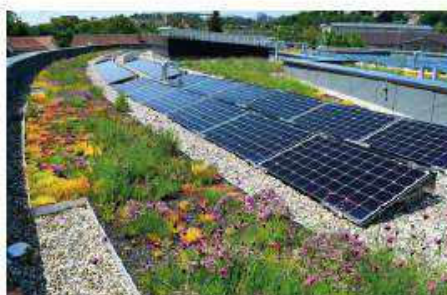
Abbildung 5: Konzept der räumlichen Trennung von Solar-Anlage und Gründach - hier auf dem kommunalen Gebäude der Stadt Tübingen.
