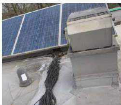
Bild 14: nicht fachgerechte Leitungsverlegung (Quelle VGH)
