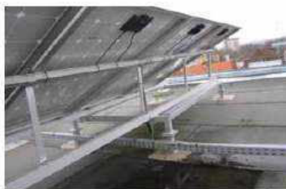
Bild 15: fachgerechte Leitungsverlegung (Quelle VGH)
