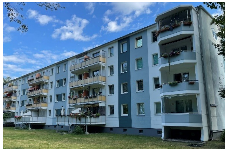
Abbildung 5: Umgebungsbebauung Erich-Lodemann-Str. 45, 47, 49, 51 Quelle: BIM Berliner Immobilienmanagement GmbH
