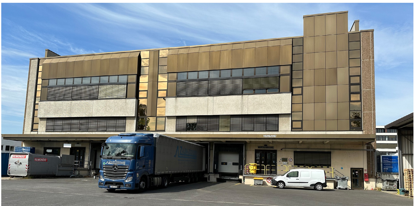
Abbildung 2: Außenansicht Produktionswerk, Anlieferungszone Quelle: GNEISE Planungs- und Beratungsgesellschaft mbH
