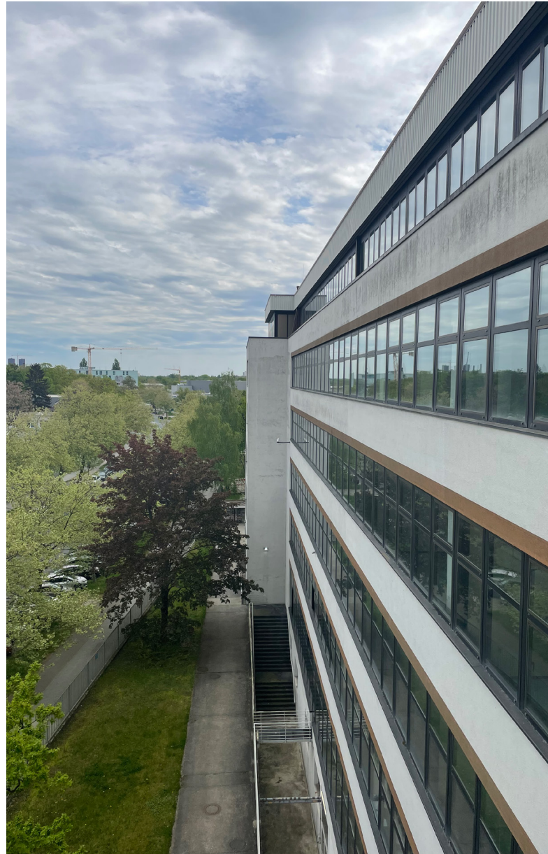
Abbildung 3: Straßenfront Verwaltungsbau Quelle: BIM Berliner Immobilienmanagement GmbH
